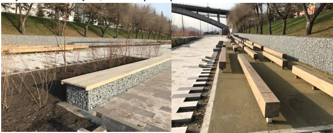
Рисунок 2. Габрионы на набережной Красноярска.
